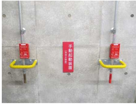
手動起動装置に保護ガードを設置
