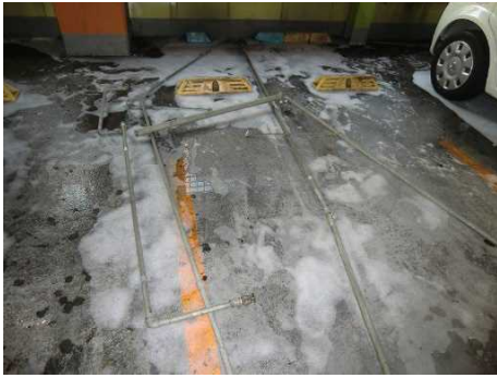
泡流出事故の例
