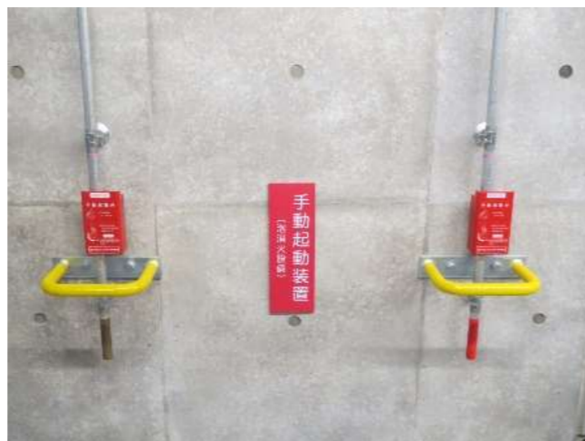
手動起動装置に保護ガードを設置
